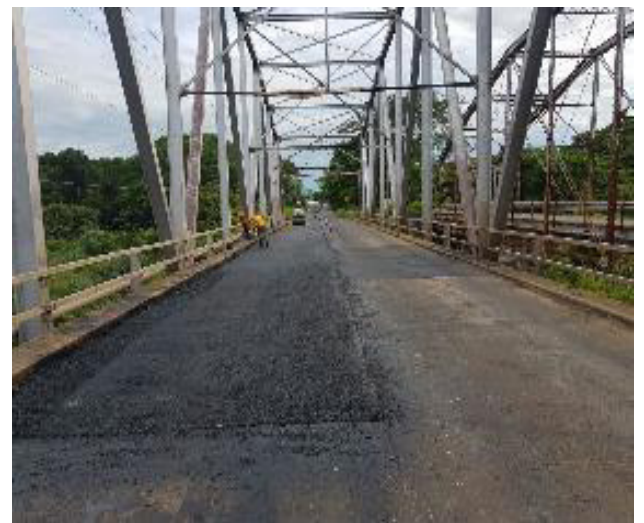
Fotografías 13-16: Trabajos de bacheo en la carpeta asfáltica de la estructura.
