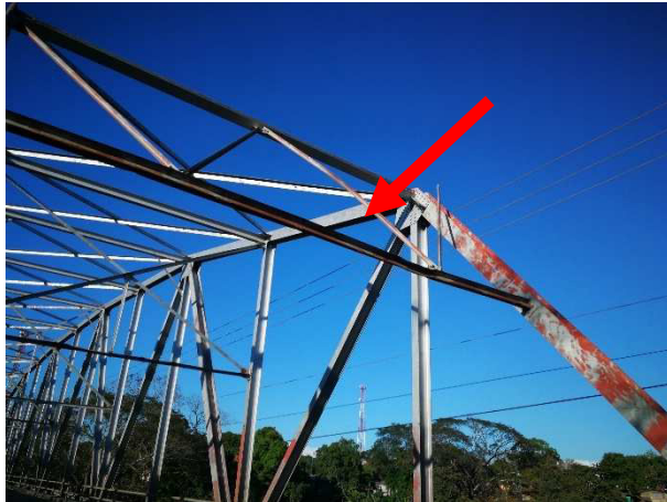
Fotografías 9 y 10. Se observan daños por colisión en la armadura en acero del puente.
