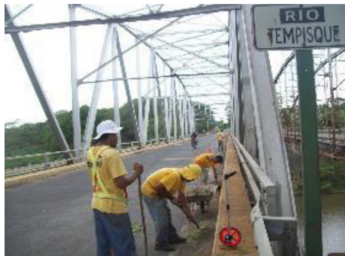
Fotografías 6-8: Trabajos de limpieza tanto para la estructura como sus drenajes.
