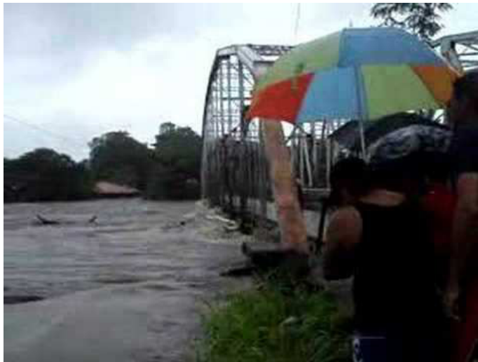
Figura 7. Puente en río Tempisque, Guardia 13 de Octubre del 2007
