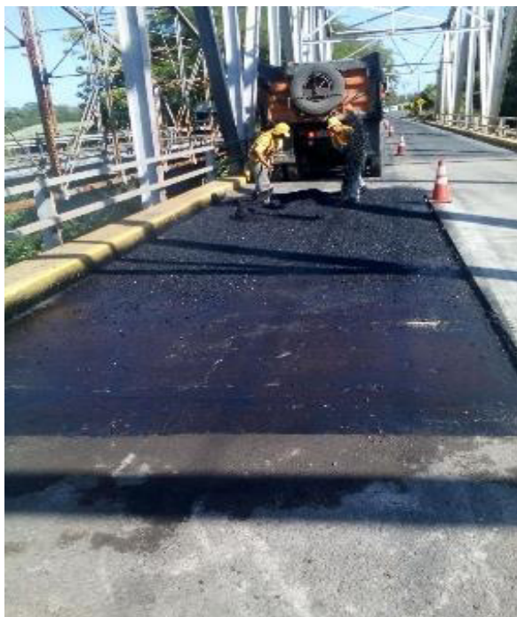
Fotografías 9-12: Trabajos de bacheo en la carpeta asfáltica de la estructura.
