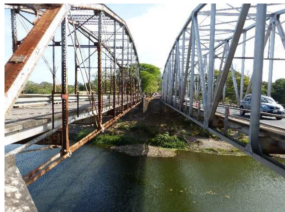
Fotografía 6. Vista lateral de puentes desde la margen derecha.
