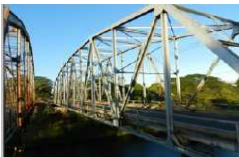
Figura 1. Fotografía general del puente
