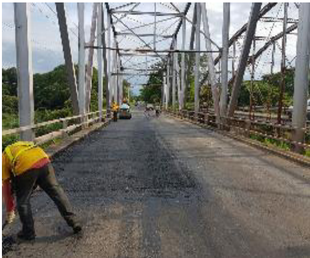
Fotografías 13-16: Trabajos de bacheo en la carpeta asfáltica de la estructura.
