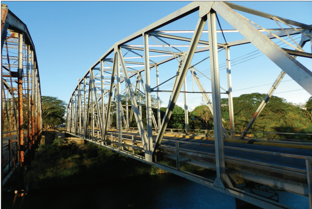
Figura 3. Vista lateral del puente Tempisque Nuevo
