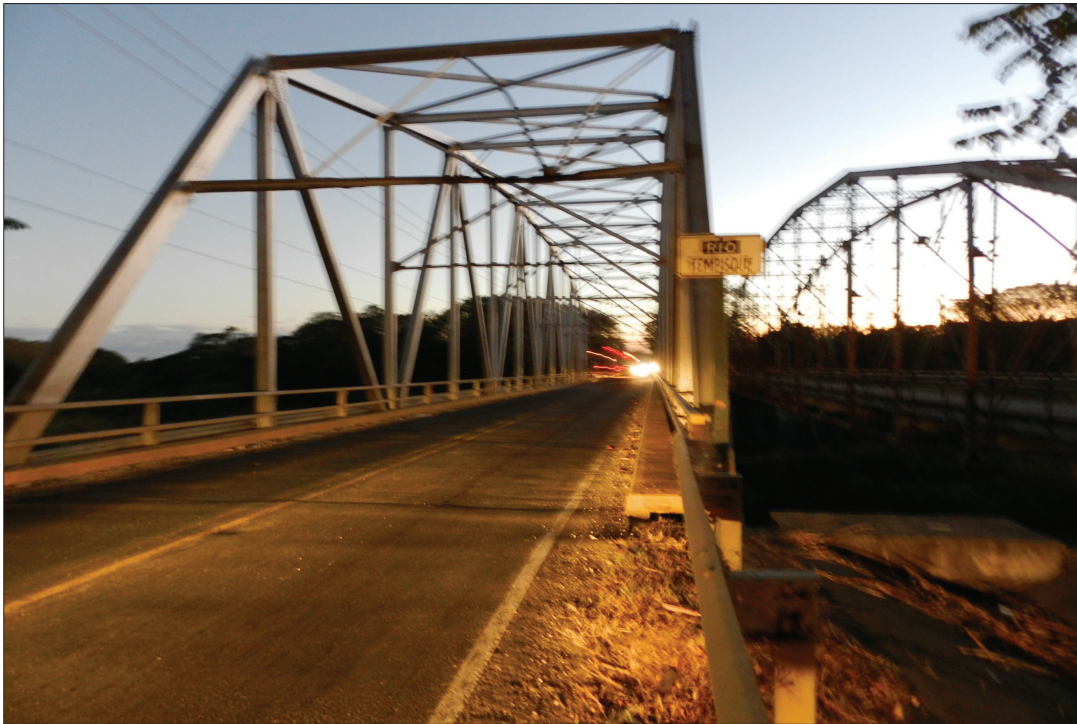
Figura 2. Vista general del puente Tempisque Nuevo
