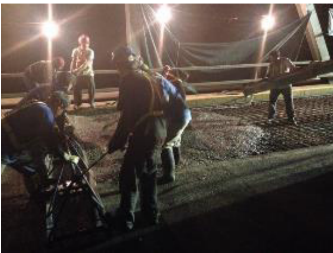
Fotografías 1-4: Trabajos para la sustitución de área dañada losa de concreto.
