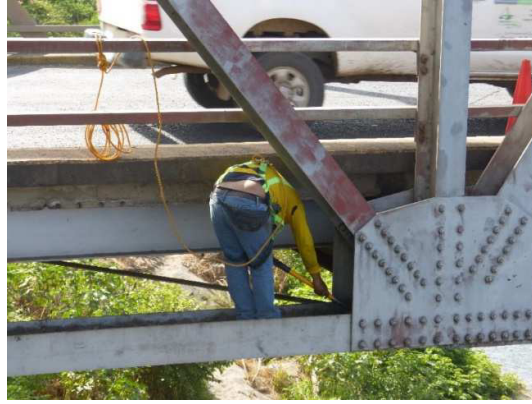
Fotografía 11. Labores de limpieza y mantenimiento en ejecución. Fuente: Elaboración propia
