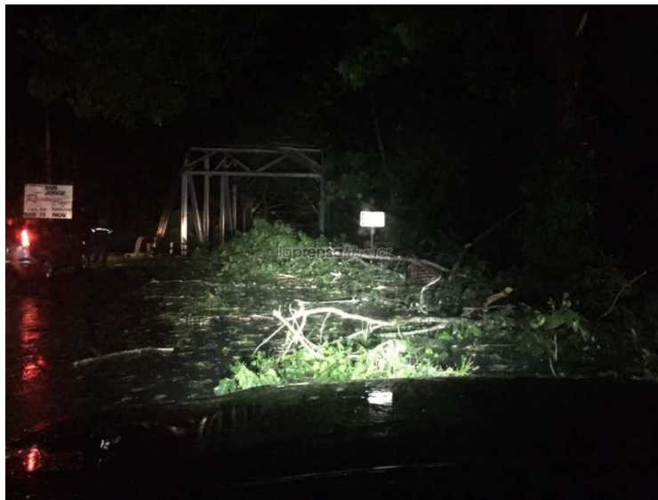
Figura 4-5. Caída de árboles en el relleno de aproximación del puente, huracán Otto
