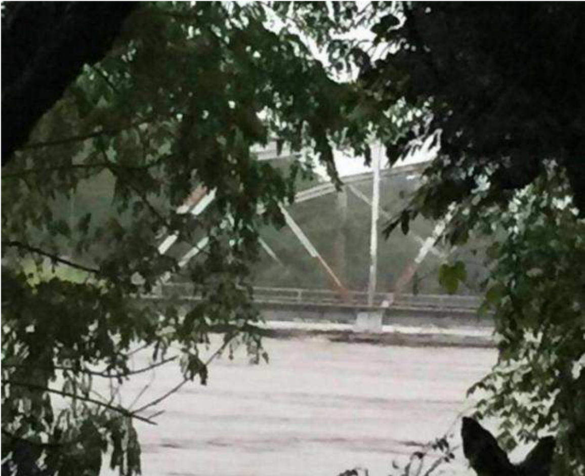
Figura 4-7. Puente en Guardia, 5 de octubre del 2017 antes de la crecida que sobrepasara el puente
