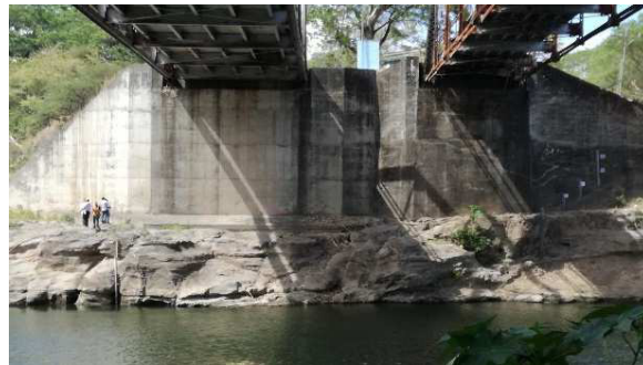
Fotografía 9. Bastiones cimentados sobre roca en la margen izquierda. Fuente: Elaboración propia
