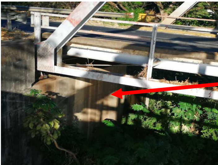
Fotografía 4. Bastión Norte se observan marcas de escorrentía superficial por falta de drenajes.
