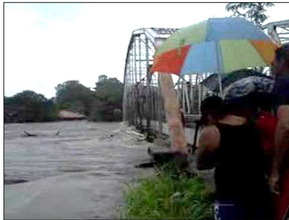
Fotografía 4. Afectación del puente con el caudal tocando la estructura.
