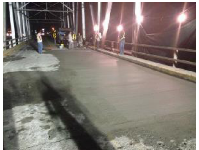
Fotografías 1-4: Trabajos para la sustitución de área dañada losa de concreto.
