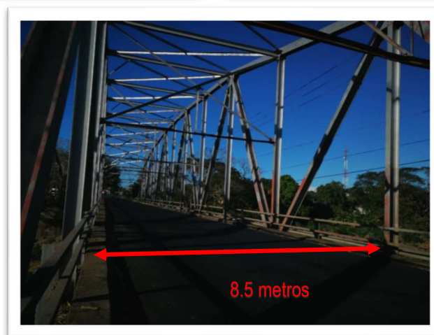
Fotografías 1, 2 y 3. Puente sobre Río Tempisque Ruta Nacional N°21
