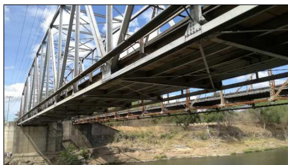
Fotografía 2. Estructura del puente en uso.
