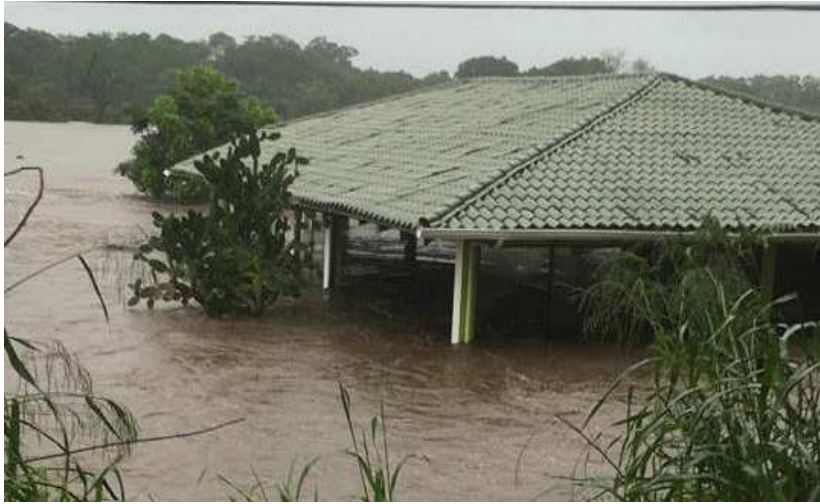
Figura 11. Zona de inundación aguas arriba del puente
