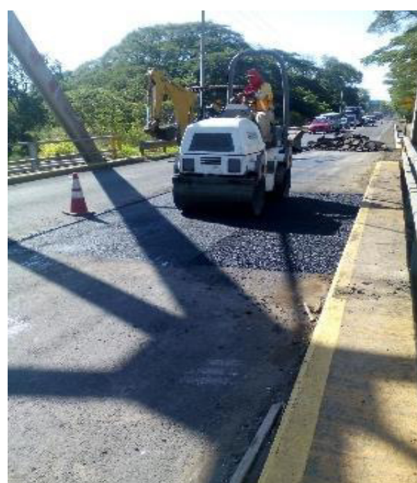
Fotografías 9-12: Trabajos de bacheo en la carpeta asfáltica de la estructura.
