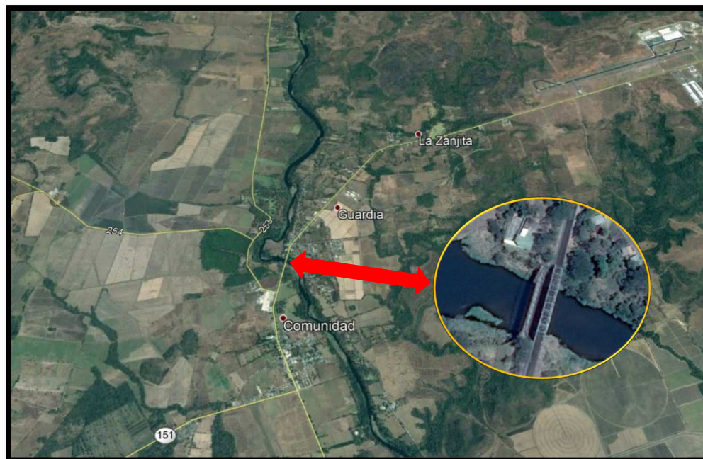
Imagen 1. Ubicación del puente sobre Río Tempisque tomada de Google Earth
