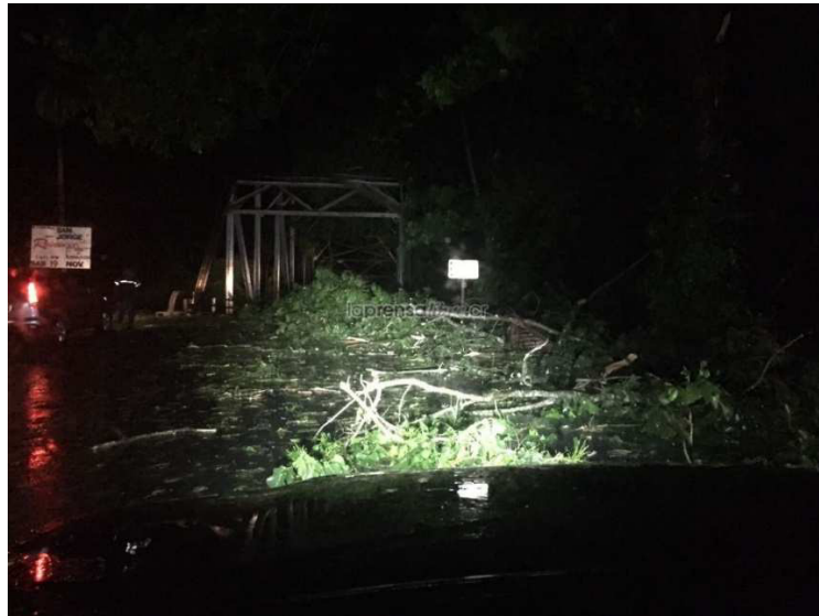
Figura 10. Caída de árboles en el relleno de aproximación del puente, huracán Otto
