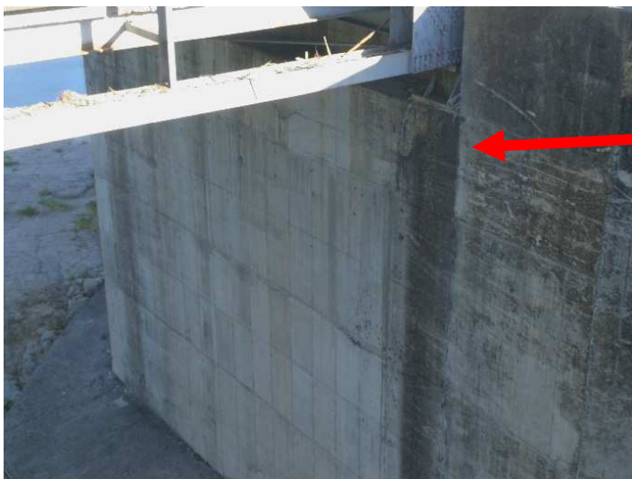
Fotografía 5. Bastión Sur se observa zona humedad por fuga de agua.
