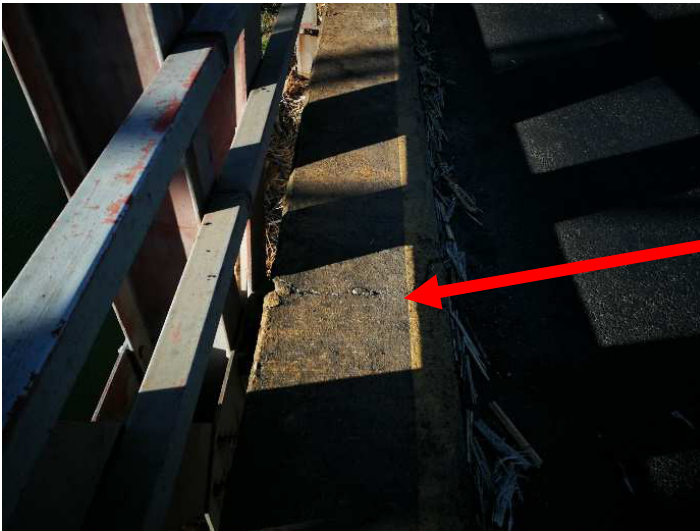
Fotografía 7. Se observan fisuras en losa de concreto.
