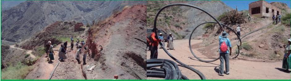
Proceso de excavación y tendido de tuberías, mostrando el trabajo organizado de la comunidad
